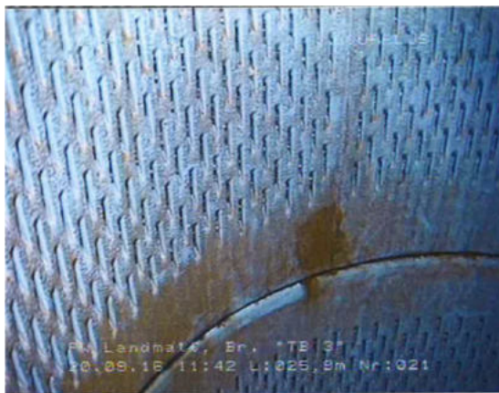
Bild Nr. 21 Tiefe: -25,9 m Im Filter; geringe Ablagerungen am Filterrohr; die Filterschlitz sind offen; eine Rohrverbindung ist erkennbar
