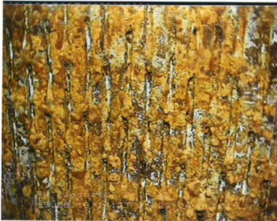
Bild Nr. 19 Tiefe: -23,0 m Im Filter; Ablagerungen und vor allem Korrosionen am Filterrohr; die Filterschlitz sind größtenteils verschlossen
