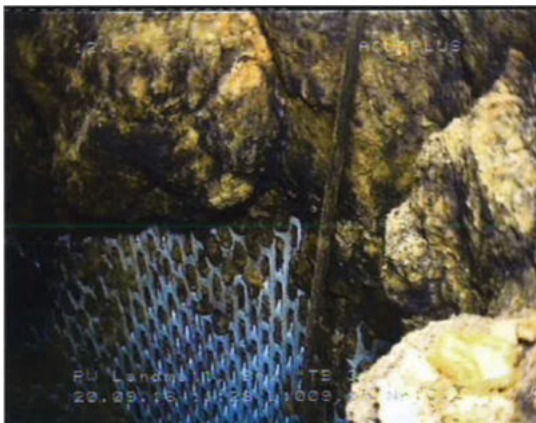
Bild Nr. 12 Tiefe: -9,1 m Im Aufsatzrohr; Blick auf den Filterbeginn; starke Ablagerungen an der Rohrwand und in den Filterschlitz
