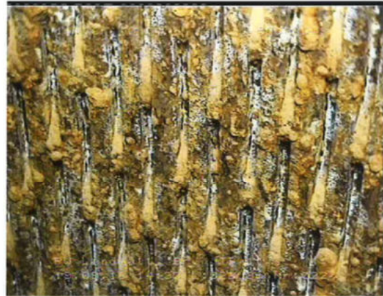
Bild Nr. 22 Tiefe: -28,8 m Im Filter; Ablagerungen und vor allem Korrosionen am Filterrohr; die Filterschlitz sind größtenteils verschlossen
